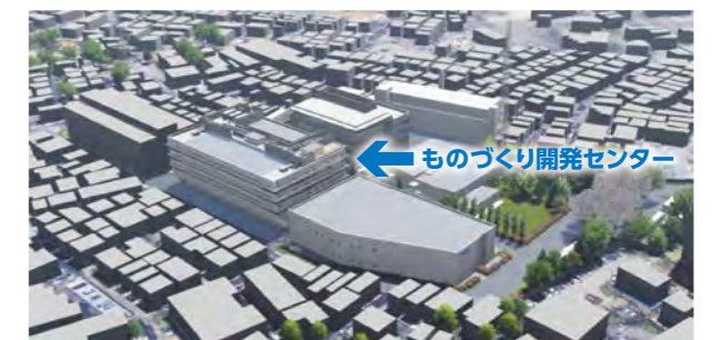
ものづくり開発センター外観(本社)
