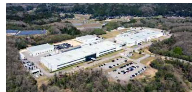
▲石川サンケン堀松地区 全景 敷地面積:306,543m 2 延床面積:全体24,680.46m 2
