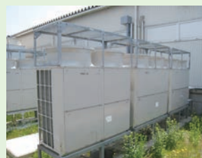
更新後の 「屋外機(空冷パッケージ) 同じものを20か所
