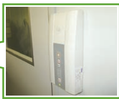
分解室入口の電子錠
