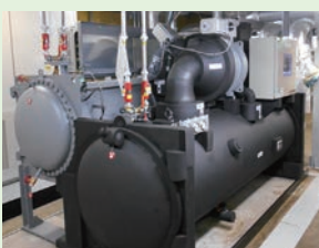
更新後の「ターボ冷凍機」
