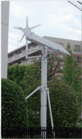
ハイブリッドシステム LED 街路灯× 1 基
