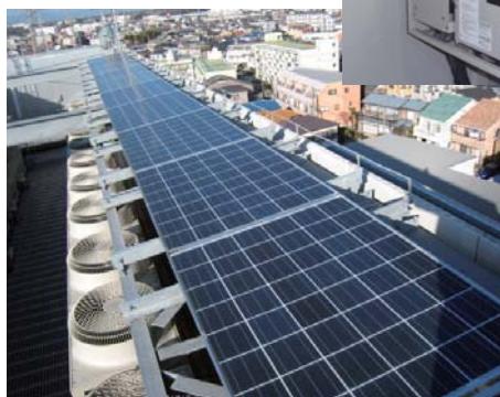
【太陽光パネル】
